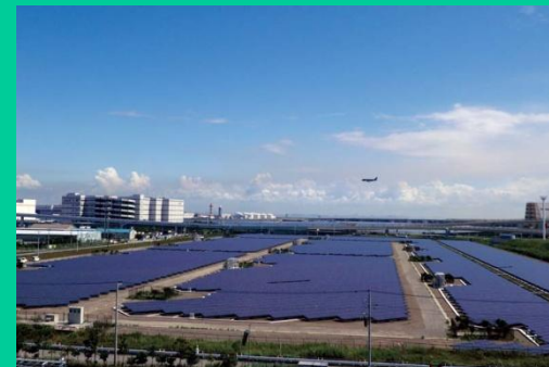
浮島太陽光発電所
