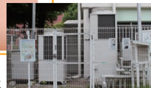
地中熱利用空調システム Geothermal air conditioning system
