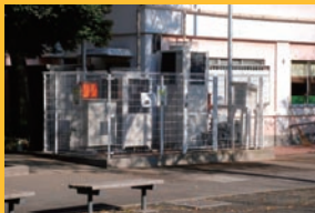
設備設置状況
