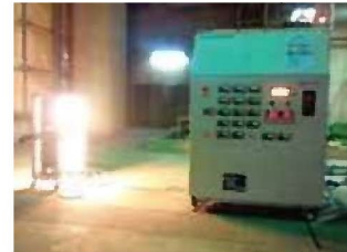
排水の温度差を利用した発電システム
