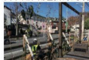
外のベンチで食事をとる工事作業員
