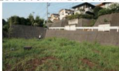
擁壁とスウェールの様子
