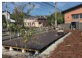
ウッドデッキ
