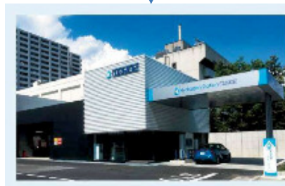
水素ステーション
