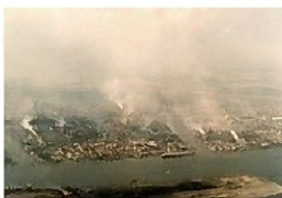
臨海部に工場が進出（1965） 川崎港管理センター The advance of factories at coastal area (1965)
