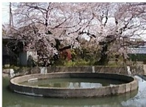
1941年に完成した 二ヶ領用水久地円筒分水
