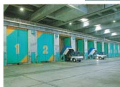
ピット投入口
